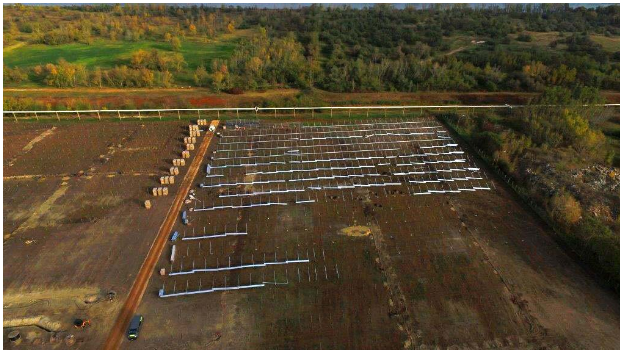
Snímek elektrárny ve výstavbě pořízený dronem.
